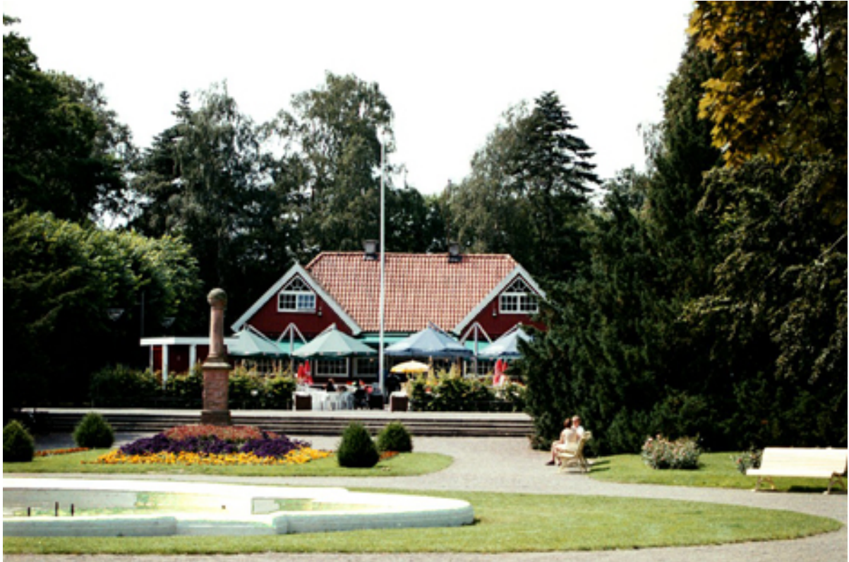
Fasaden bevaras. Stadsparkskaféets fasad ska bevaras efter ombyggnaden. Arkiv: Ulrika Walmark 1998
