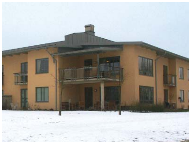
Solhällan, Eslöv, nybyggnad
