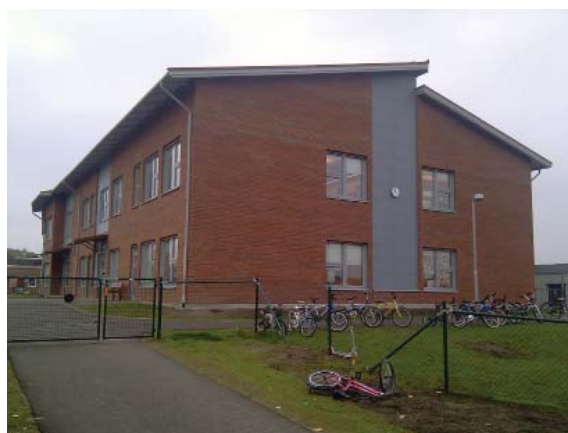
Härkebergaskolan, Genarp, ny-ombyggnad
